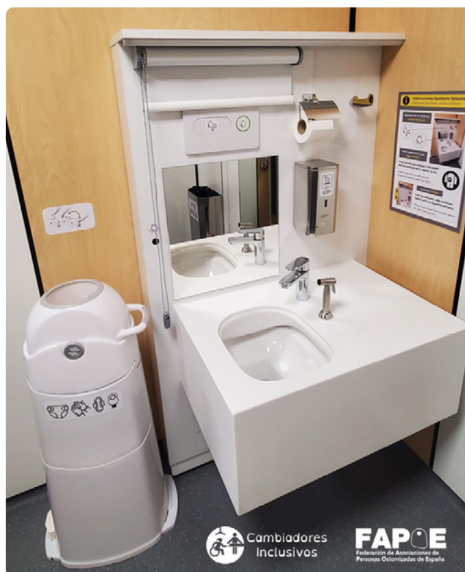
Imagen 2: sanitario de ostomía prefabricado con elementos y especificaciones propias para ser ubicado dentro de un cambiador inclusivo.
