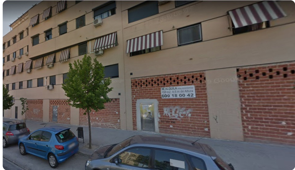
Barrio periférico. Locales sin actividad. Sensación de edificio y ciudad sin terminar. Fuente: Google Maps.
